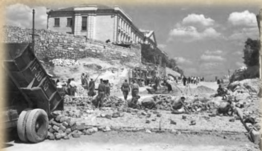
Строительство троллейбусной трассы на Корабельном спуске.
